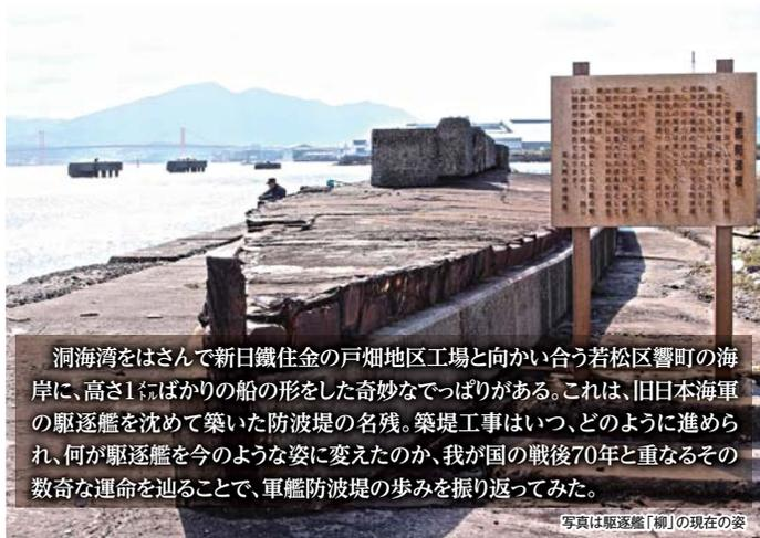
洞海湾をはさんで新日鐵住金の戸畑地区工場と向かい合う若松区響町の海岸に、高さ1.1mばかりの船の形をした奇妙なでっぱりがある。これは、旧日本海軍の駆逐艦を沈めて築いた防波堤の名残。築堤工事はいつ、どのように進められ、何が駆逐艦を今のような姿に変えたのか、我が国の戦後70年と重なるその数奇な運命を辿ることで、軍艦防波堤の歩みを振り返ってみた。
