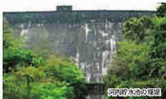
河内貯水池の堰堤
